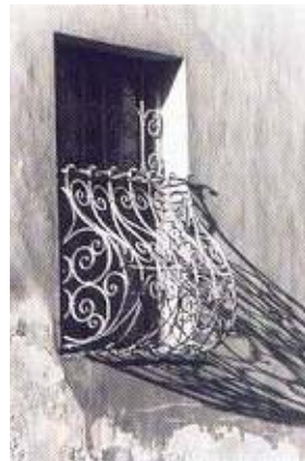
Die schöngebauchten Fenstergitter mussten von der Straßenseite aus Sicherheitsgründen zum Innenplatz hin verlegt werden.
