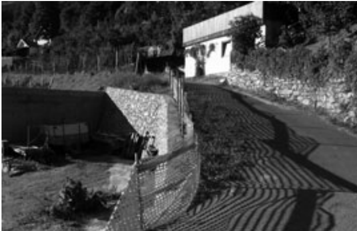
Scharfe Linkskurve in der Vogelsangstraße wurde verbreitert.
