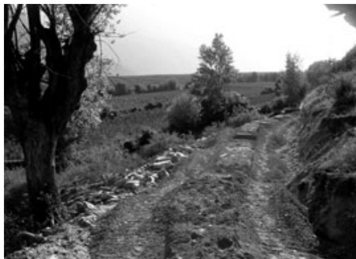
Erdbewegungsarbeiten unterhalb des Zahlwaaes
