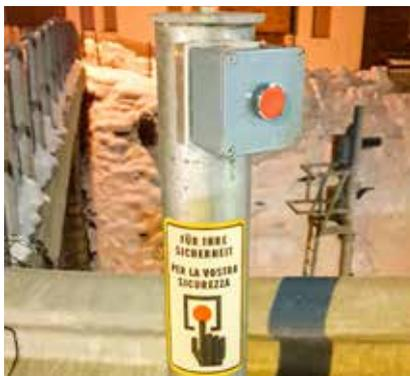
*Durch Drücken des roten Knopfes wird das blinkende Warnsignal ausgelöst*
